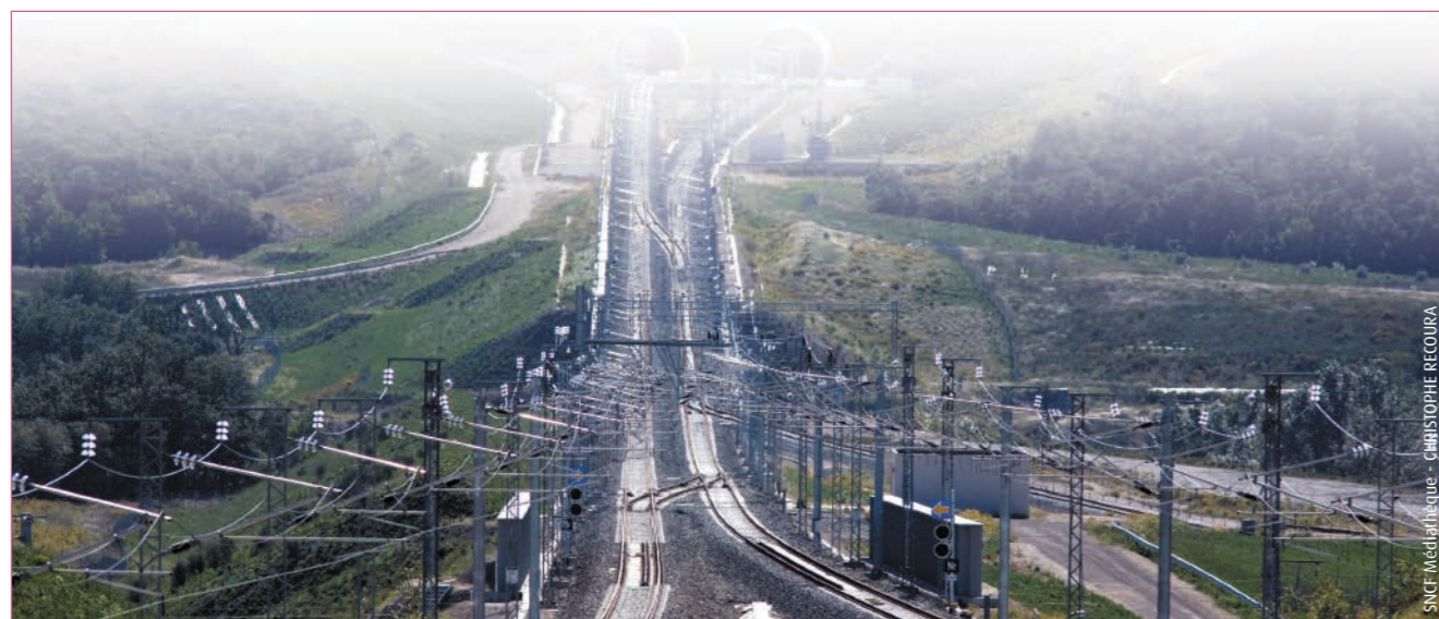
Tunnel du Perthus (Partie Nord) permettant aux TGV de franchir la frontière franco-espagnole sur la ligne à grande vitesse Perpignan Figueras
